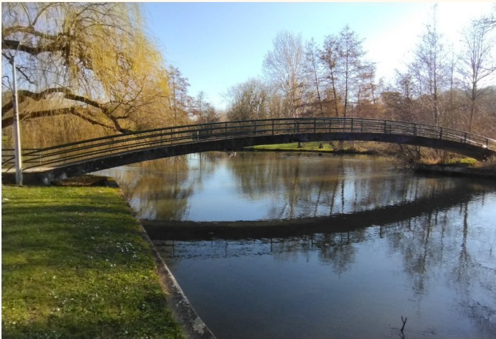
Passerelle Lac des Closiers
